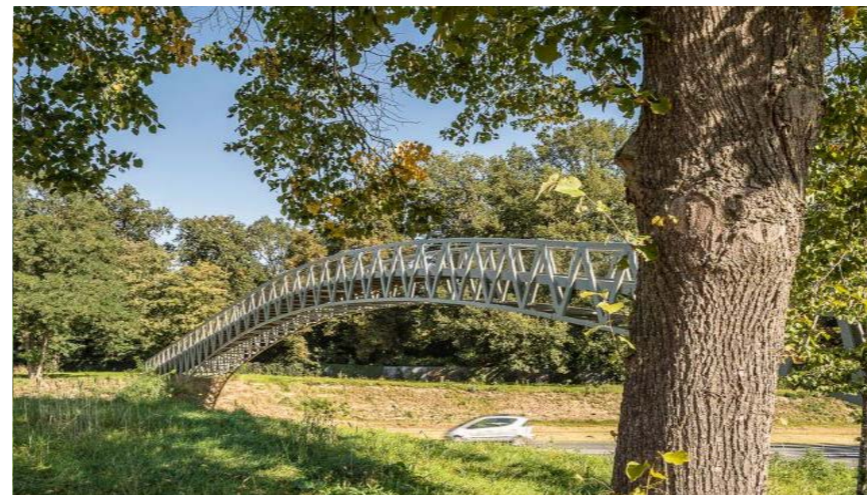
Herstellen verbinding Meeldijk over N57 met voetgangersbrug
