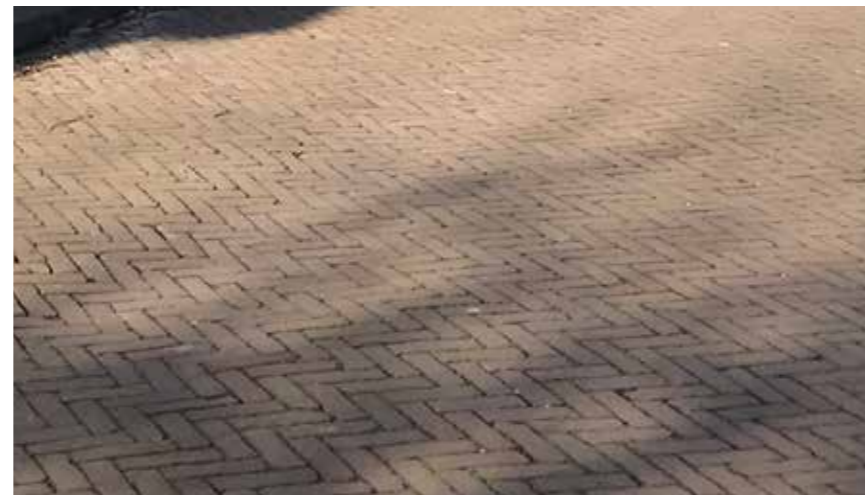
Hergebruik klinkers, rijbaan, dikformaat
