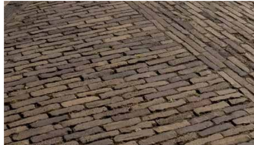
Hergebruik klinkers, trottoir en plein, waalformaat
