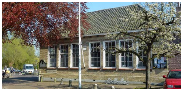
Burghse Schoole in afwijkende baksteen (bestaande kwaliteit)
