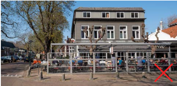
terrasafscherming blokkeert openbare ruimte (onwenselijk)
