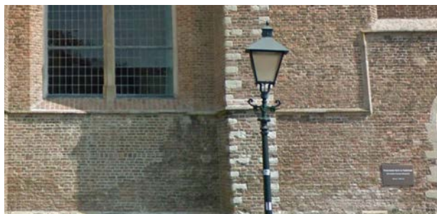
bestaande historische paaltop armaturen (bestaande kwaliteit)
