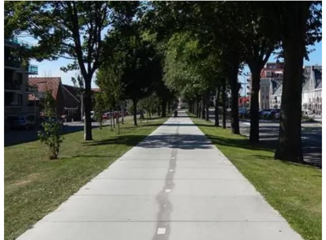
Voorbeeld fietspad met betonplaten
