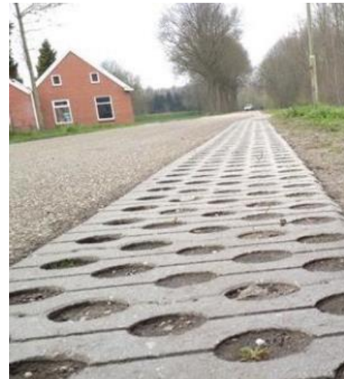
Voorbeeld van een bermbescherming
