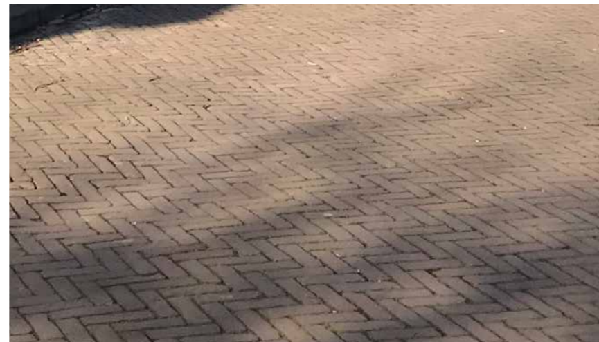
Hergebruik klinkers, rijbaan, dikformaat
