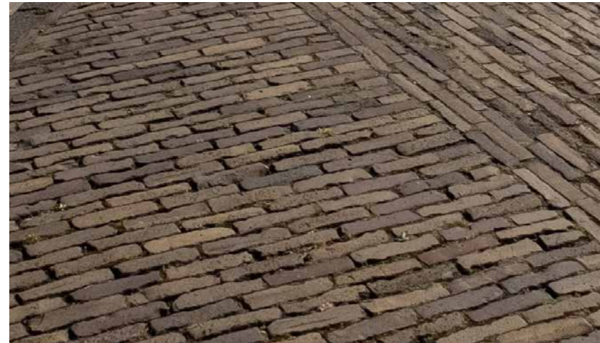
Hergebruik klinkers, trottoir en plein, waalformaat
