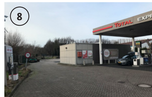
Tankstation aan de Burghseweg
