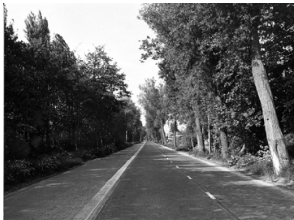
1976 - Kraaijensteinweg, Westenschouwen ter hoogte van Camping Blomshoeve
