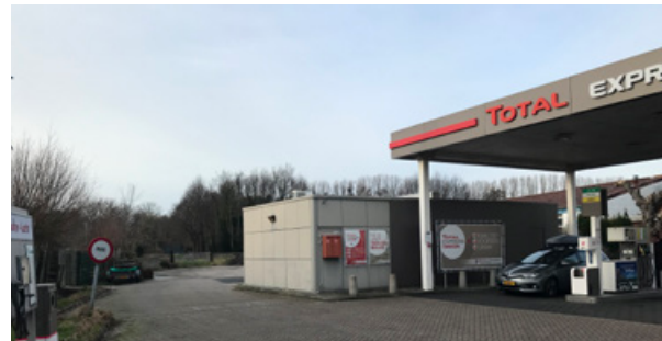
Tankstation aan de Burghseweg
